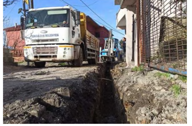
Bağlık Mahallesi Bülbül ve Kuruçeşme Sokakta 570 metre içme suyu şebeke hattı yenilenerek toplamda 55 adet bina bağlantısı yapıldı.
