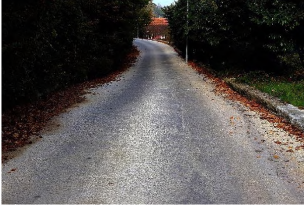
İnagzı Mh. Medine sk beton yol
