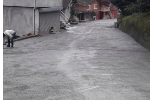
Birlik Mh. beton yol çalışması
