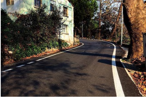
Çınartepeler Mahallesi asfalt çalışması
