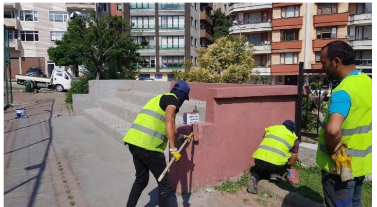
Rotary park bakım onarım
