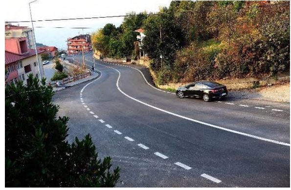
İnağzı yolu asfalt çalışması
