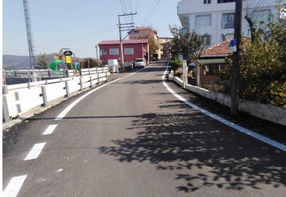
Karaelmas Mah.Şentepe Cami Mevki asfalt çalışması
