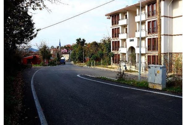
Ontemmuz mah.asfalt çalışması
