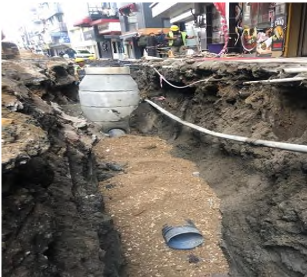
Doğramacı Sokak Kanalizasyon Hattı Yapım işi
