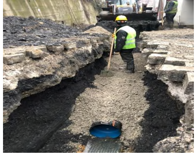
Cengiz Topel Caddesi Kanalizasyon Hattı Yapım işi
