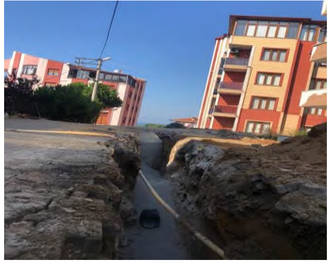
Şinasi Sokak Kanalizasyon Hattı Yapım işi
