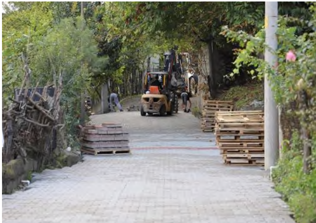
Mithatpaşa Mh. Hüsein Öztek Sk. Parke Yol Çalışması
