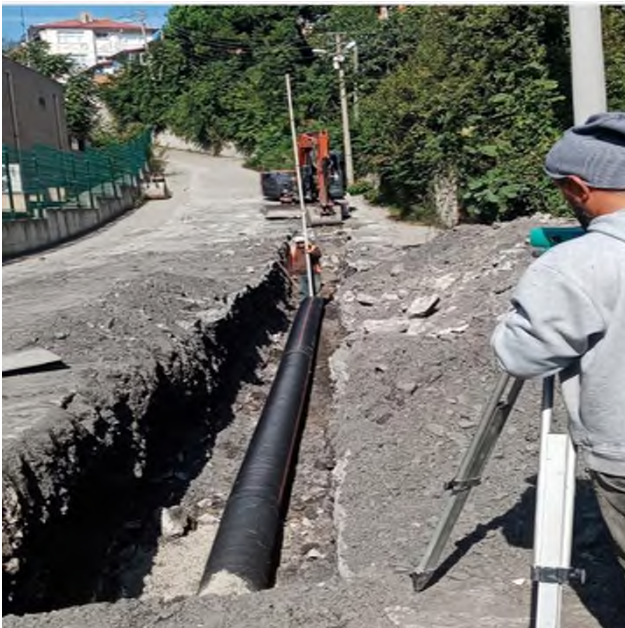
Yayla Mah. Fırın Sok. Kanalizasyon Hattı Yapım işi
