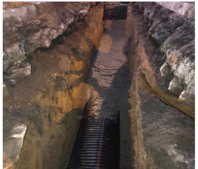
Şemsi Denizer Sokak Kanalizasyon Hattı Yapım işi
