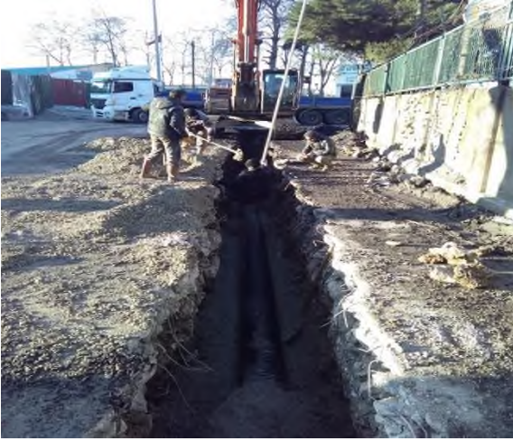
Terakki Mah. Milli Egemenlik Cad. Kanalizasyon Hattı Yapım İşi
