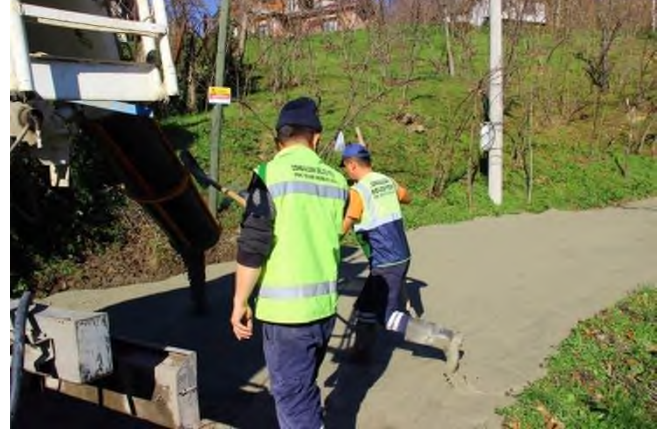
Asma-Yenişehir Sokak Beton Çalışması
