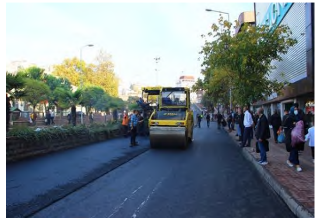
Soğuksu Asfalt Çalışması
