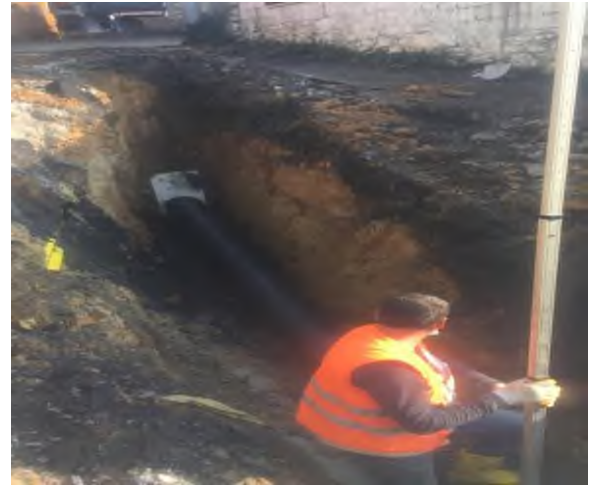
Çınartepe Mah. Baruthane Sok Kanalizasyon Hattı Yapım İşi
