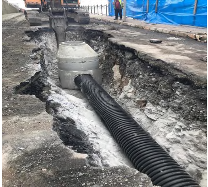
Bahçelievler Mah. Açelya Sok. Kanalizasyon Hattı Yapım İşİ
