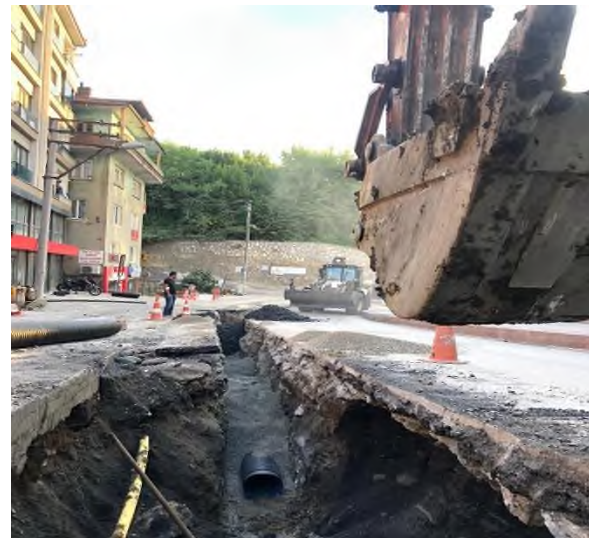
Bahattin Dökerel sokak, Huzur Sokak Kanalizasyon Hattı Yapım işi
