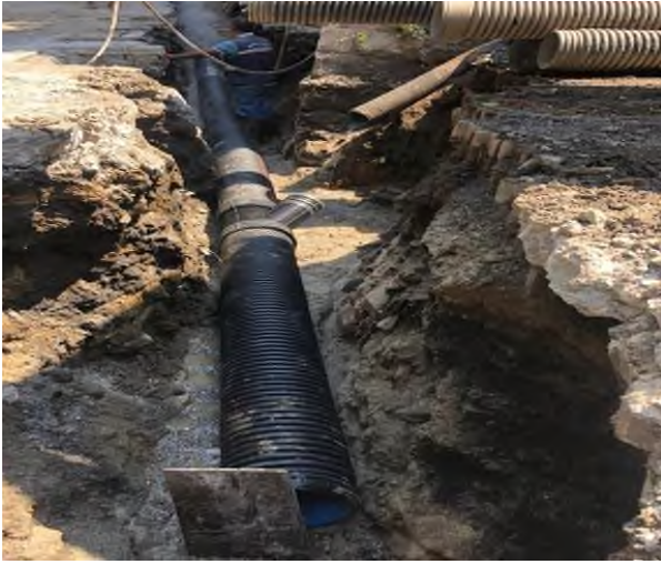
Rüzgarlı Meşe sokak Kanalizasyon Hattı Yapım işi
