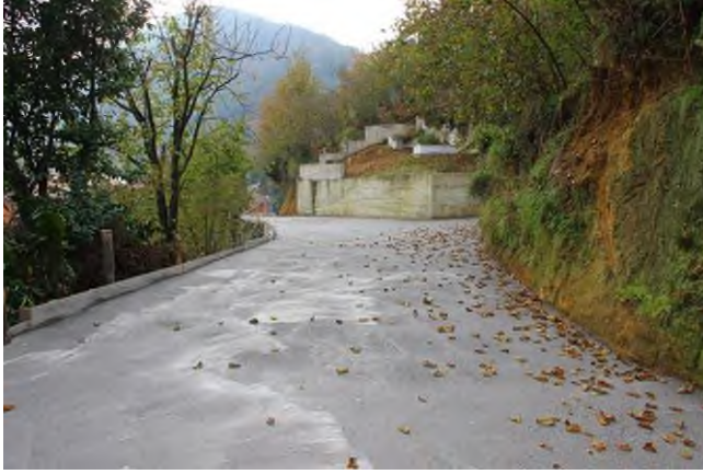
Ulubatlı Hasan Sokak Beton Çalışması
