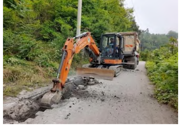
Dilaver ve Asma Mahalleleri İçmesuyu İsale ve Şebeke Yapım Çalışmaları
