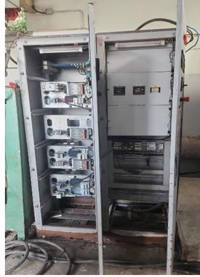
TM3 Kapuz Atıksu Terfi Merkezi Eski Elektrik Panoları
