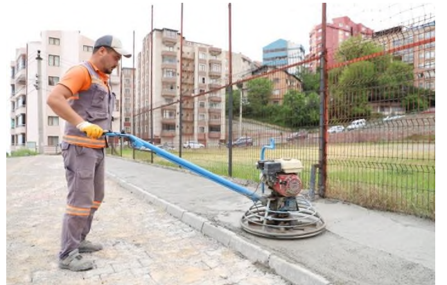
Tepebaşı-Hakkı Hilalci Sokak. İmam Hatip kaldırım helikopter beton düzleme çalışması
