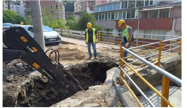
Kadırga rampa yağmur hattı altyapı çalışması
