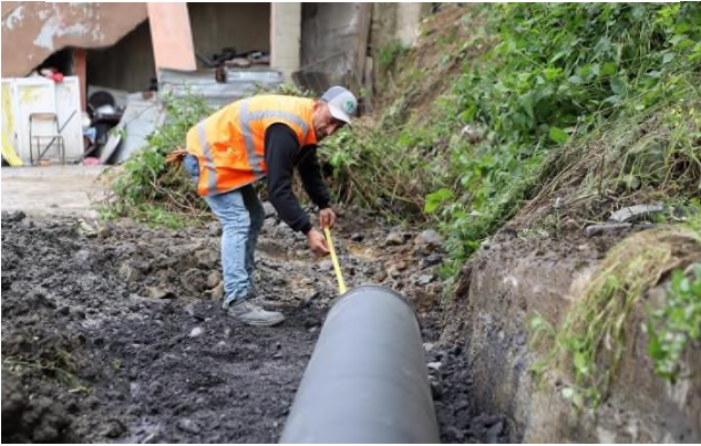
Karaelmas Fındıksuyu yağmur suyu hattı çalışması
