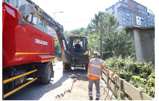
Tepebaşı Mahallesi 88 Evler Sokak Parke çalışması
