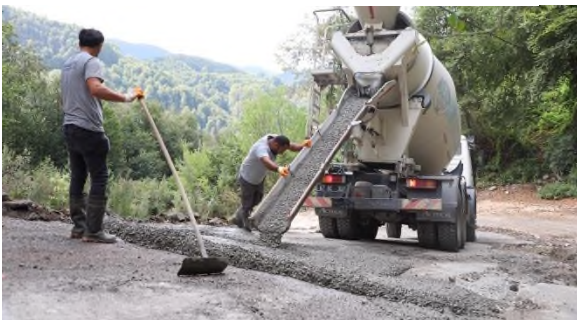
Dilaver-Elma Sk. Beton yol çalışması
