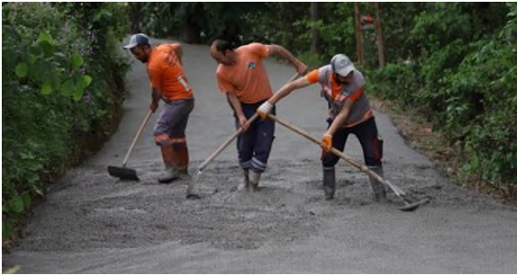
Asma Egemen Sk. Beton yol çalışması
