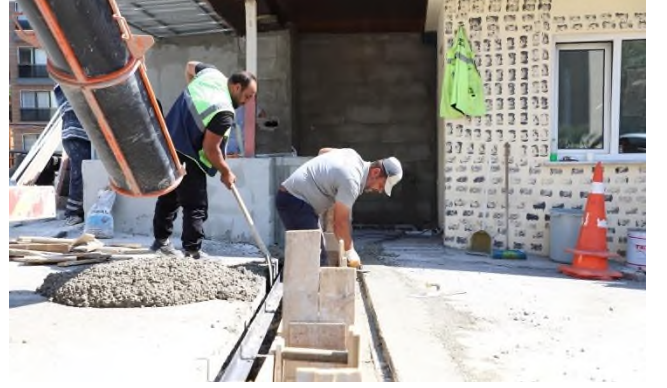
Bahçelievler Ergenekon Sokak Yağmur suyu hattı çalışması
