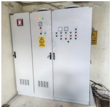
TM4 Uzunkum Atıksu Terfi Merkezi Yenilenmiş Elektrik Panoları
