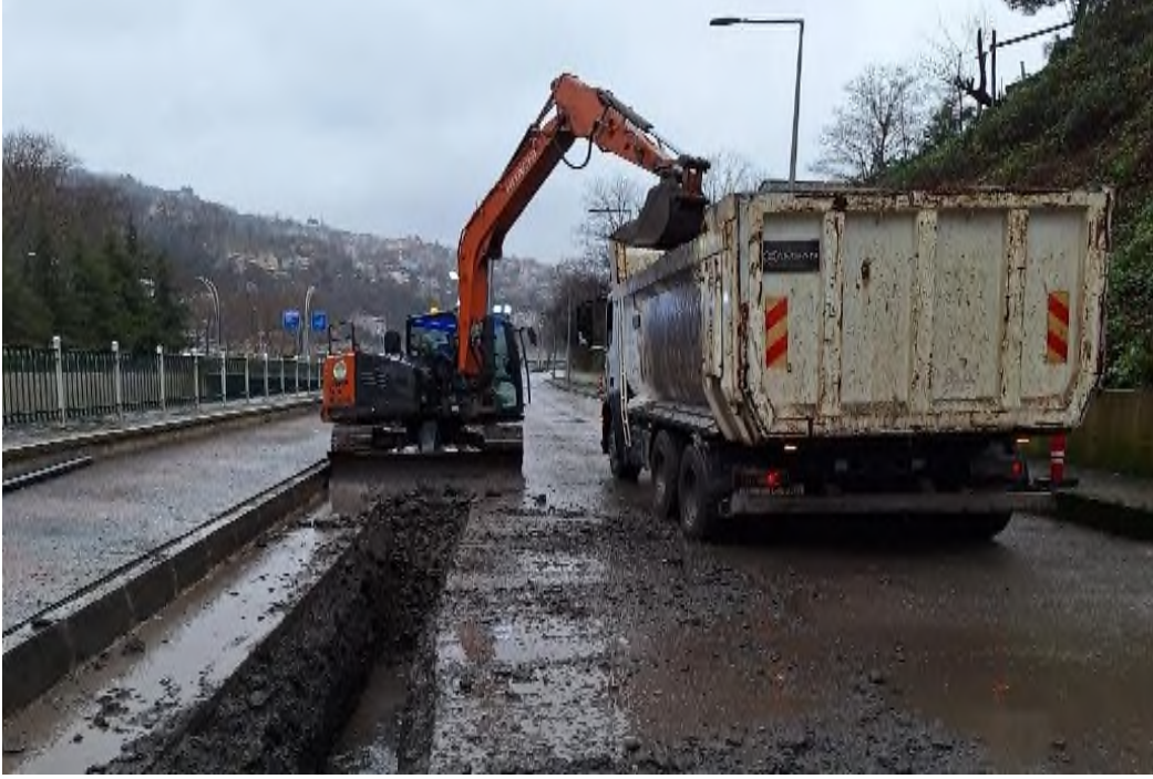
Hal Arkası Asbest Hatların PE100 Boru İle Yenilenmesi Çalışması
