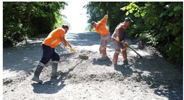
Terakki mah Gazipınar Sokak Beton yol çalışması
