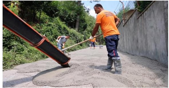
çaydamar aş evi mevki beton yol çalışması
