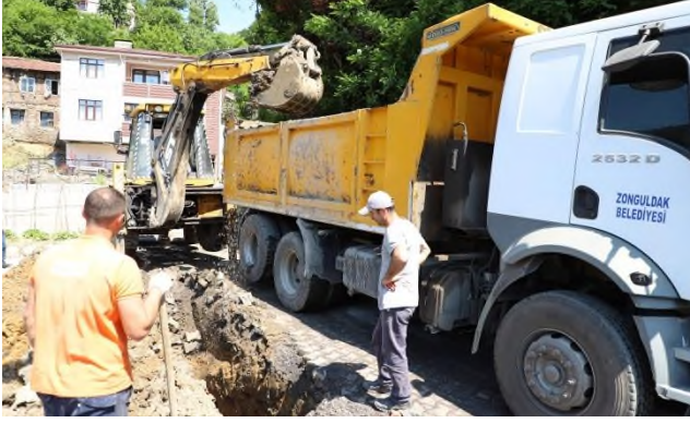
Asma Mh Kömürlü Sokak Yağmur suyu hattı çalışması
