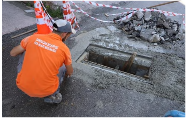
Meşrutiyet mah Huzur Sokak Yağmur suyu hattı çalışması
