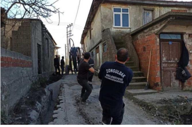
Mithatpaşa Mahallesi 708 Sokakta su problemi yaşayan 15 adet binanın bağlantıları yenilenerek 100 metre içme suyu şebeke hattı döşendi.
