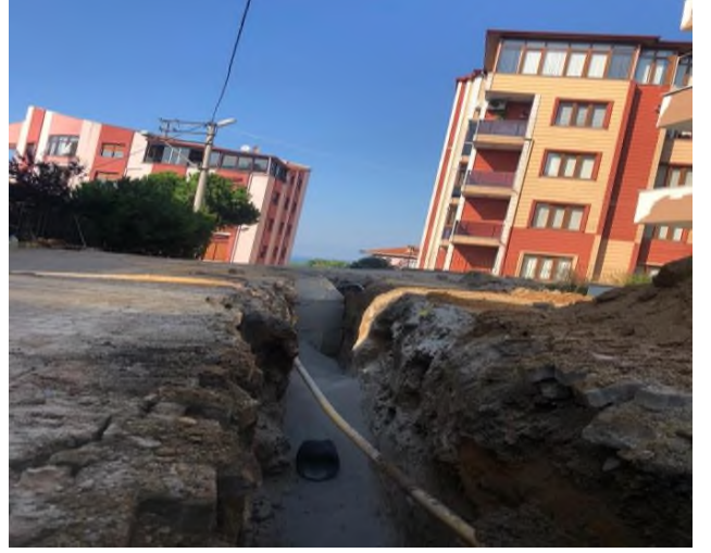
Şinasi Sokak Kanalizasyon Hattı Yapım işi
