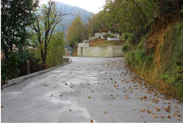
Ulubatlı Hasan Sokak Beton Çalışması
