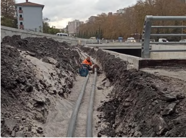
Karaelmas Mahallesi Fındıksuyu Sokak
