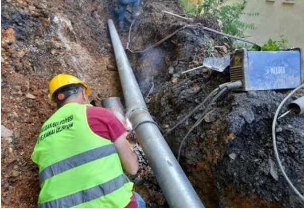
Tepebaşı Mahallesi Taşocağı Sokak
