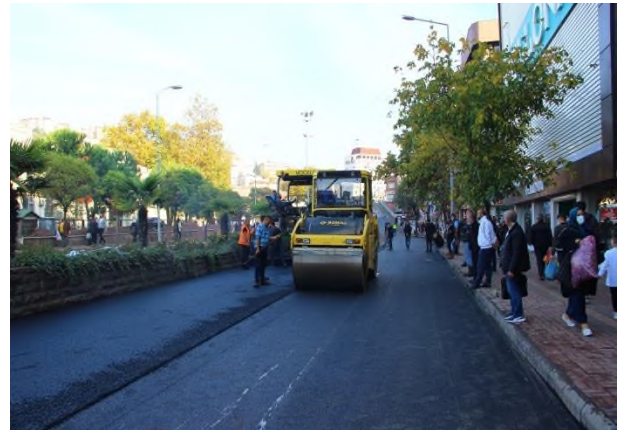
Soğuksu Asfalt Çalışması
