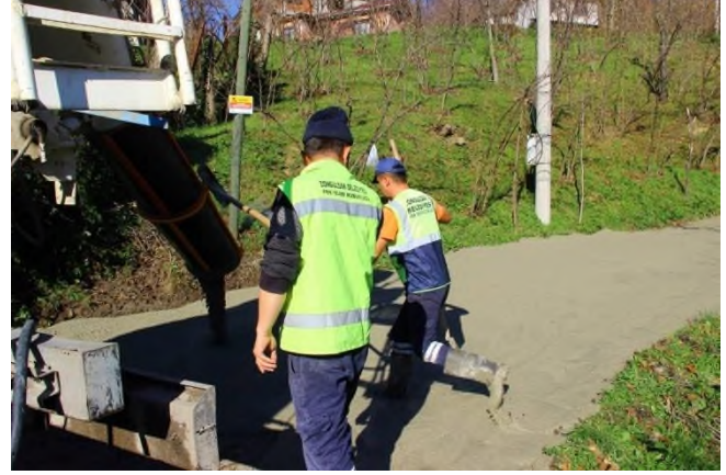
Asma-Yenişehir Sokak Beton Çalışması
