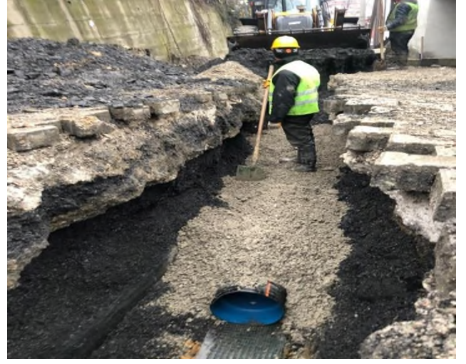
Cengiz Topel Caddesi Kanalizasyon Hattı Yapım işi
