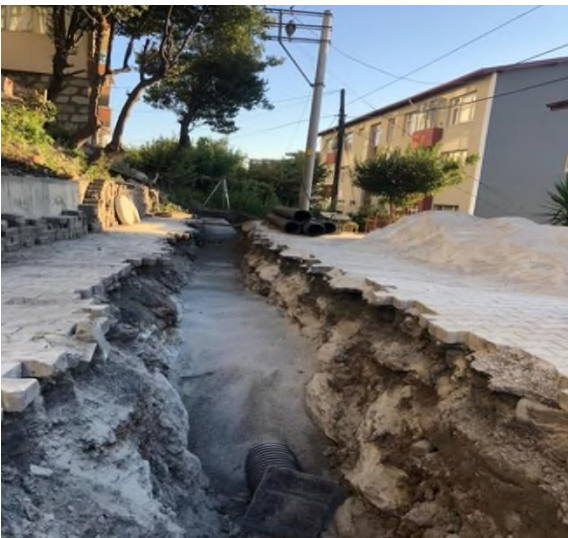
46 Küme Evler sokak Kanalizasyon Hattı Yapım işi
