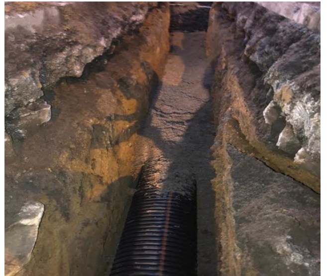
Şemsi Denizler Sokak Kanalizasyon Hattı Yapım işi
