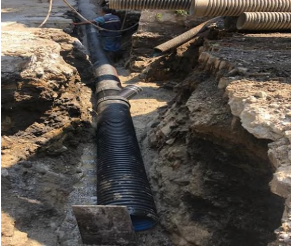
Rüzgarlı Meşe sokak Kanalizasyon Hattı Yapım işi
