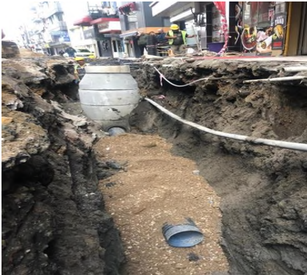
Doğramacı Sokak Kanalizasyon Hattı Yapım işi
