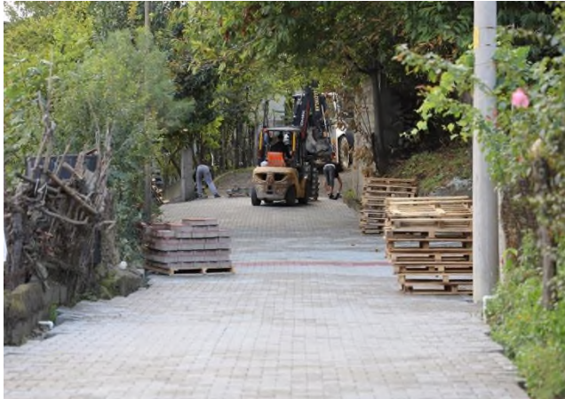
Mithatpaşa Mh. Hüsevin Öztekin Sk. Parke Yol Çalışması
