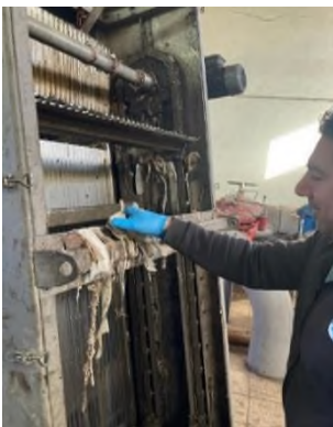
Atıksu Arıtma Tesisi idaresine bağlı Terfi Merkezlerinin kafes temizliği günlük olarak yapıldı.
