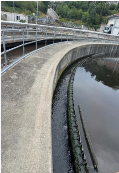
Atıksu Arıtma Tesisi Son Çökeltim Havuzu savakları düzenli olarak temizlendi
