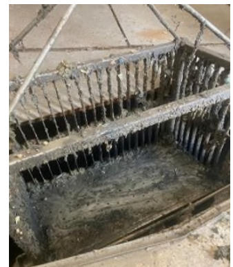
Atıksu Arıtma Tesisi idaresine bağlı Terfi Merkezlerinin kafes temizliği günlük olarak yapıldı.
