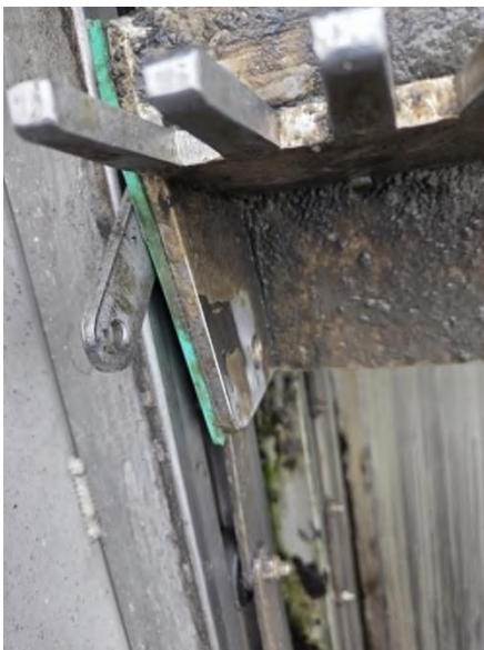
Atıksu Arıtma Tesisi Mekanik Kaba-İnce Izgara Prosesi yıl boyunca bakım ve onarımı
